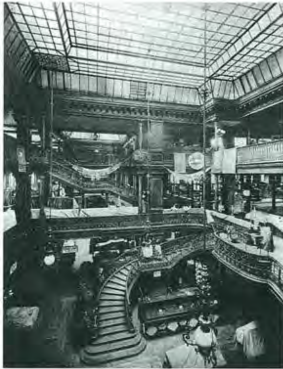
Figure 3.2 Au Bon Marché (Paris), escalier vers 1900 (Archives Moisant-Savey)
